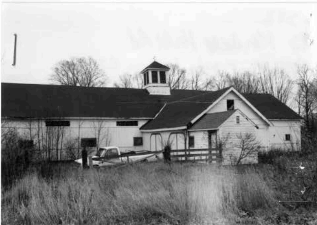
Barn-side looking ESE. 11/00.
