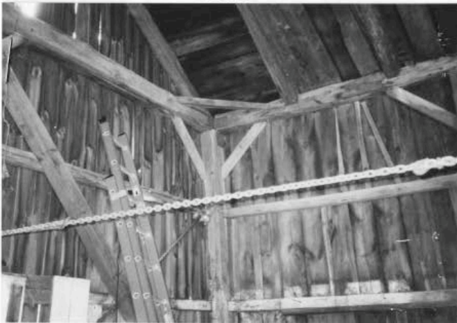
Barn - NE corner. 2001.
