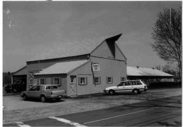
70 Flanagan Hill Rd - Barn (STE.399). 4/01.
