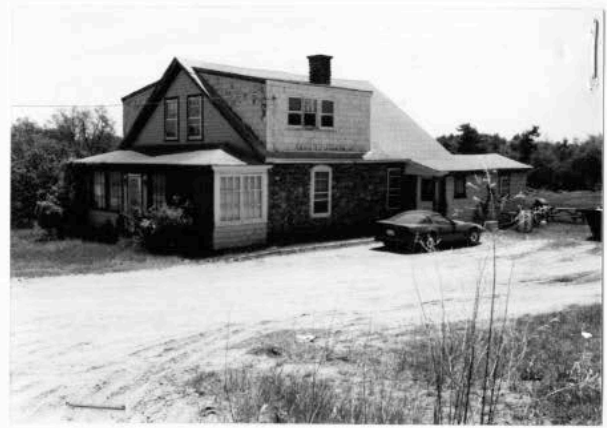
10 Merrill Road (STE. 423). 2001.
