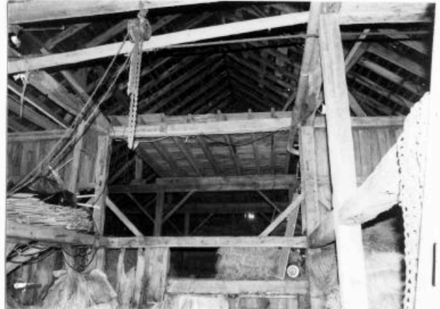
View NW - barn (STE. 532). 2001.
