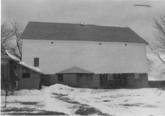
Side elevation of barn (STE. 387). 1/01.
