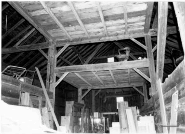
Barn (STE. 34) center aisle facing N. 2001.
