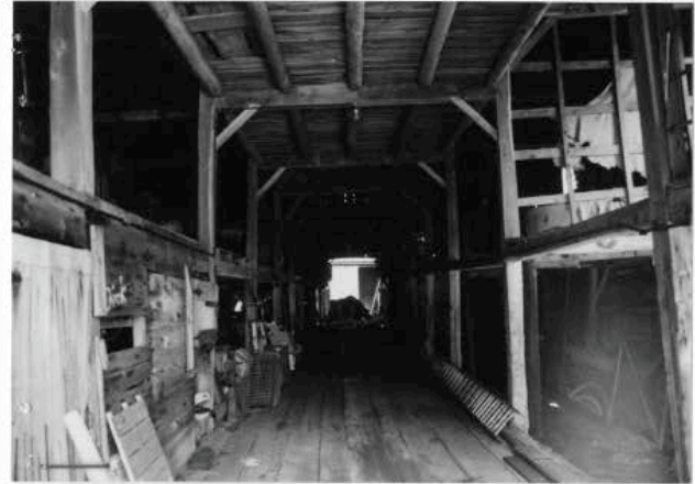
Barn-center aisle (STE.444). 5/01.
