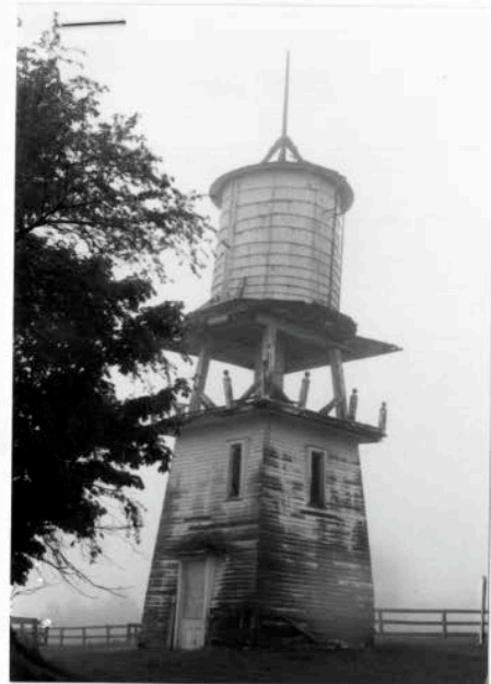
Water tank (STE. 985). 2001.
