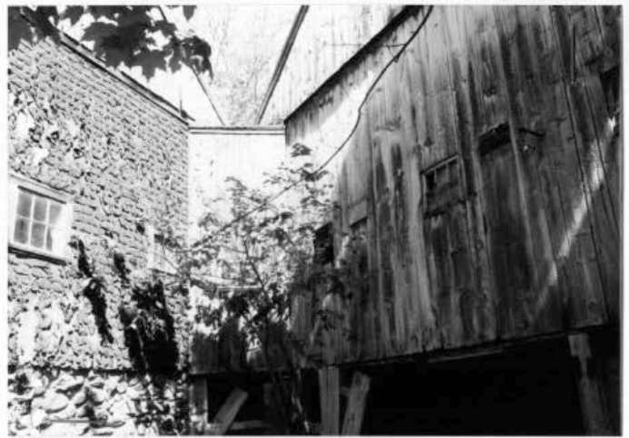
(STE. 459) and south barn (STE. 460). 2001.
